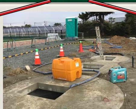
↑ 浄化槽工事の様子
